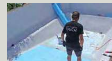
6. Boden stumpf oder überlappend verlegen.
